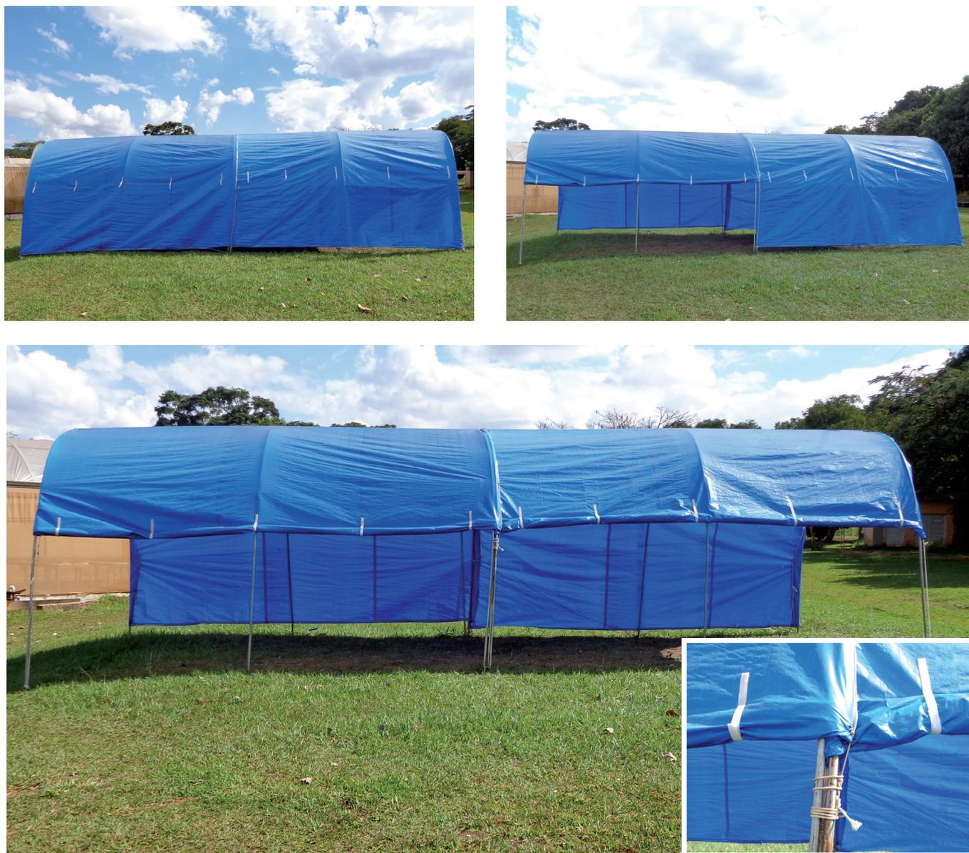
**Figura 6 – Abertura e ventilação da estrutura e fixação da lona com velcro.**
