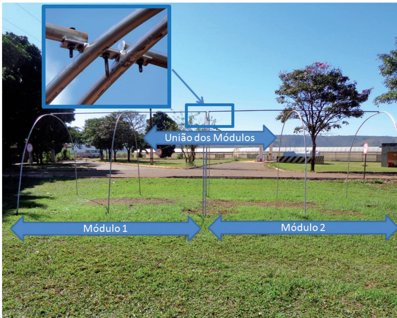
Figura 2 – Montagem e União das duas UMS.
