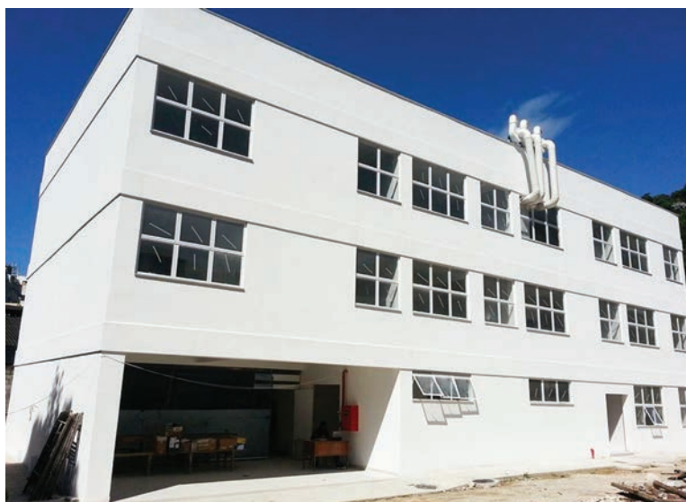
Figuras 58, 59 e 60. Novo prédio do LASP.
