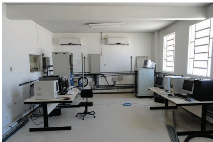
Figura 18. Sala dos servidores do NTI antes reforma.
