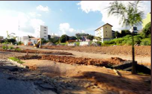
Manutenção nas estruturas de saneamento, Campinas, SP. | Foto: Cristina Criscuolo.
