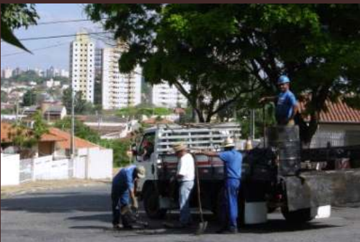
Manutenção de vias públicas, Campinas, SP. Foto: Cristina Criscuolo.
