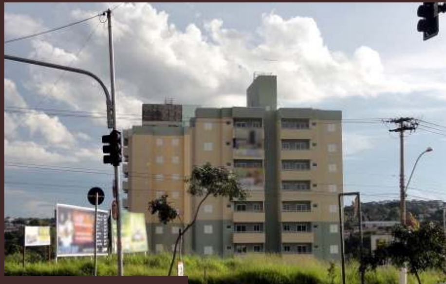
Construção de unidades habitacionais. O mercado imobiliário disponibiliza novas opções de moradias, que atraem população da RMC. Foto: Cristina Criscuolo.
