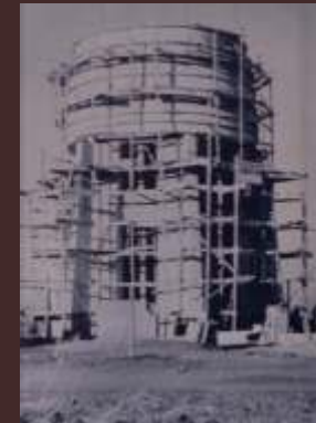
Construção da Torre do Castelo, entre 1936 e 1940. Foto: Acervo Histórico-Cultural da Sanasa.
