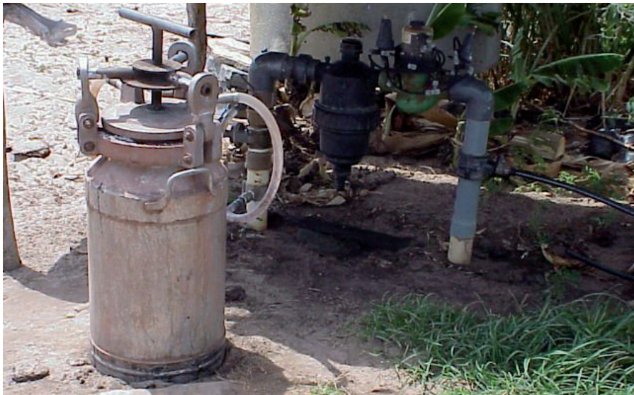
Figura 6. Tanque de diferencial de pressão utilizado na fertirrigação.
