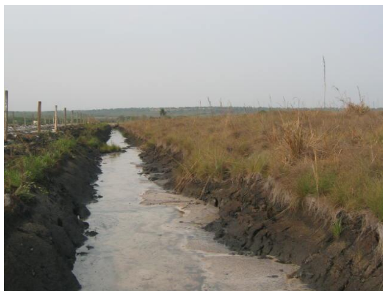
Figura 22B ĩ Canal de drenagem em área de Organossolo Háplico (perfil PCG ĩ 09) assoreado com areia proveniente de locais mais elevados fora da várzea.
