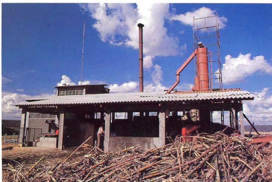
Fig. 4 — Microdestilaria de produção de etanol desenvolvida pela EMBRAPA para o auto-suprimento energético de propriedades rurais.
