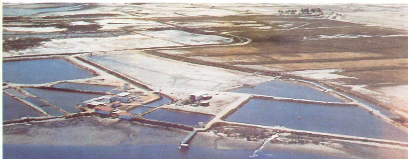
Fig. 46 — Vista panorâmica do Projeto Camarão da EMPARN.
