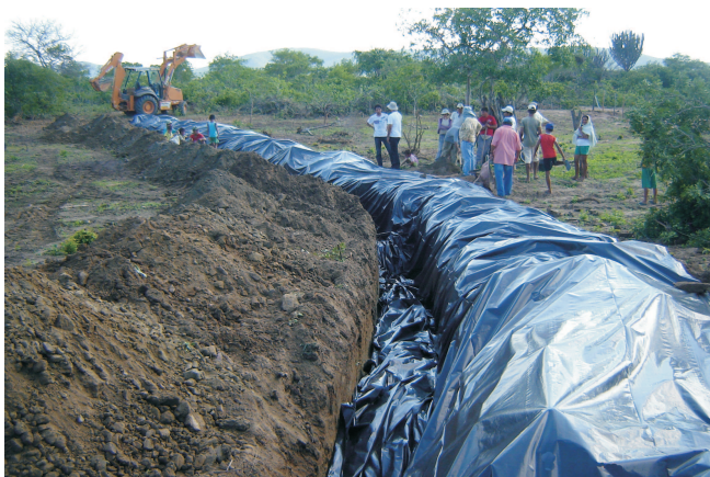
Figura 7. Colocação da lona na vala.
