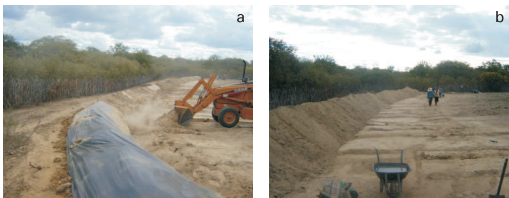
Figura 9. Fechamento da vala (a) e detalhe da formação da parede (b).
