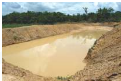
Construção dos viveiros
