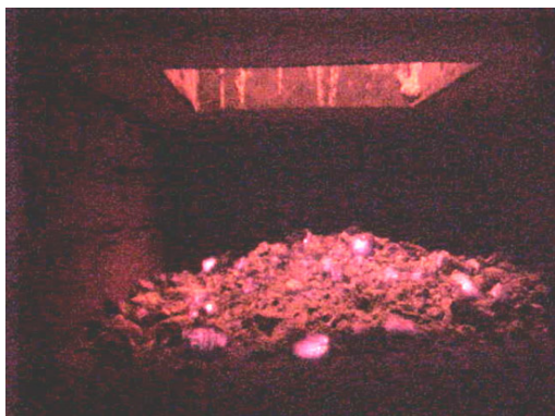
Figura 31. Detalhe do interior do cinzeiro mostrando a complementação da combustão.
