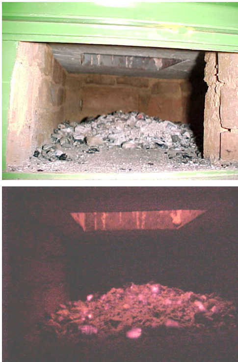
Figura 13. Compartimento cinzeiro onde é mostrada abertura na laje da câmara de combustão por onde caem as cinzas.
