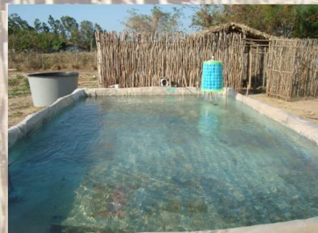
**Figura 8.** Vista do tanque de 5.000 L construído com plástico e papelão. Ao fundo, o galinheiro.
