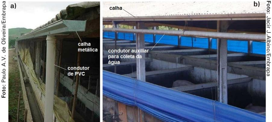
**Figura 4.** Exemplos de calha coletora e condutor auxiliar em telhados de granjas
