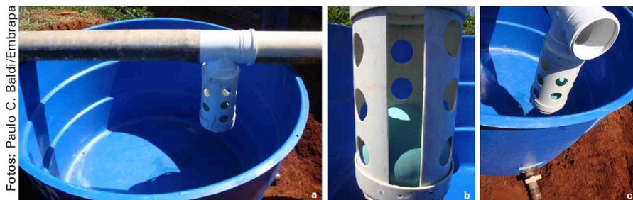
**Figura 7.** Exemplo de reservatório para descarga da primeira água da chuva
