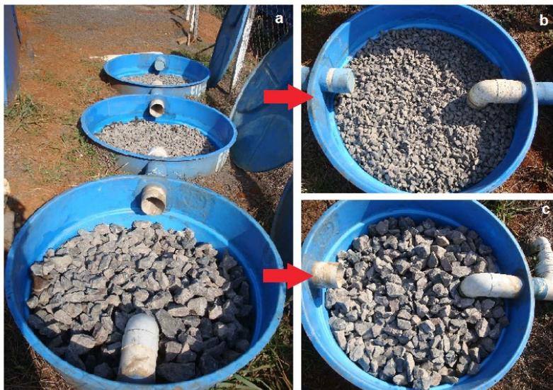
**Figura 9.** A. Sistema de filtração rápida em três caixas de fibra: com pedra marroada (tamanho médio de 5-6 cm, conforme detalhe Figura 9C), brita nº 2 e brita nº 1. B. Observa-se o último filtro de passagem rápida antes da cisterna, com brita nº 1.
