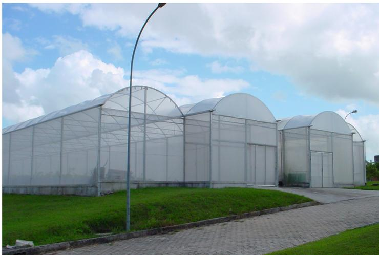
**Figura 13.** Viveiro-telado com cobertura plástica do polímero polietileno, usada para minimizar a queda de temperatura do interior da estufa.
