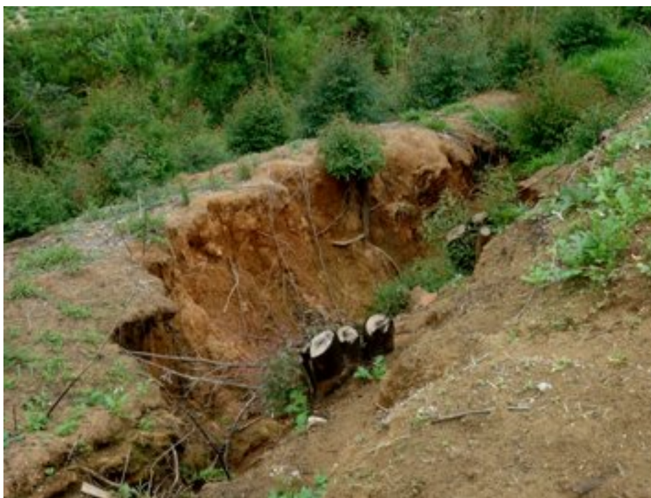
Figura 3: Voçoroca identificada em área de plantio de eucalipto. Foto: Tiago de A. Chaves.
