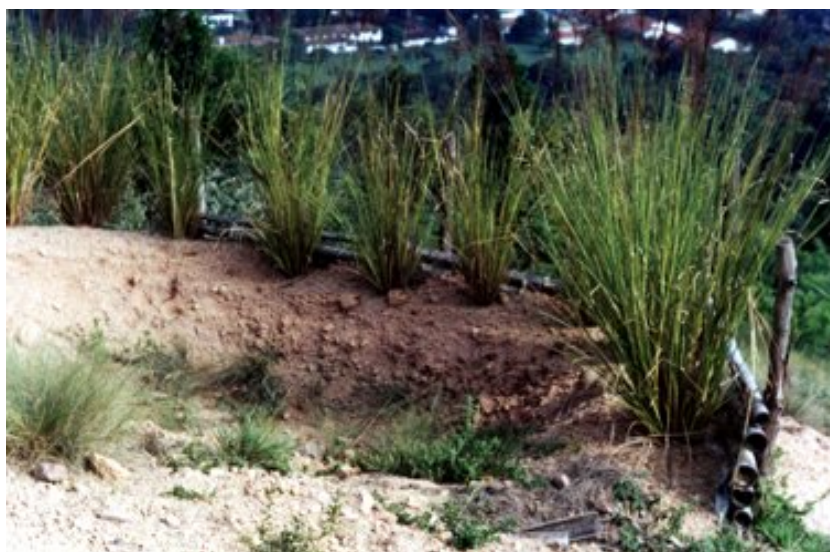
Figura 4. Bacia de captação – observa-se a presença do capim Vetiver, plantado nos limites da bacia para proteção contra a erosão. Foto: Aluísio Granato de Andrade.
