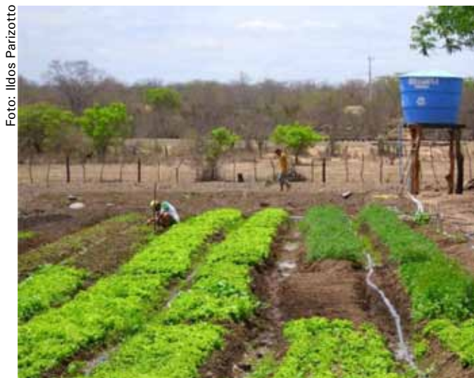
Figura 1. Sistema de irrigação de baixa pressão com uso de reservatório elevado para distribuição de água por gravidade.
