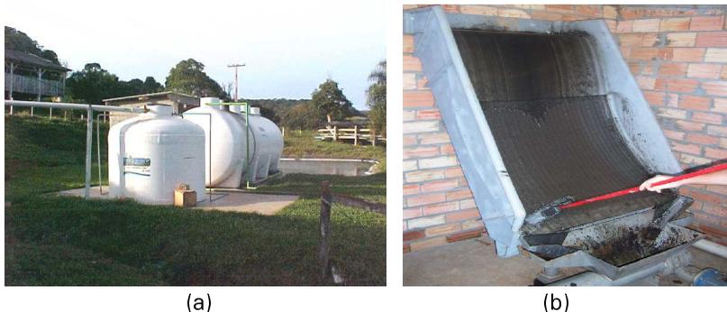
**Fig. 1.** Vista geral do sistema compacto Mizumo® instalado na Escola Agrotécnica Federal de Concórdia – SC para o tratamento de dejetos de suínos (a) e detalhe da peneira com prensa para separação de fases (b).
