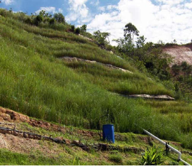
Fig. 12. Controle de erosão oferecido pelo vetiver.
