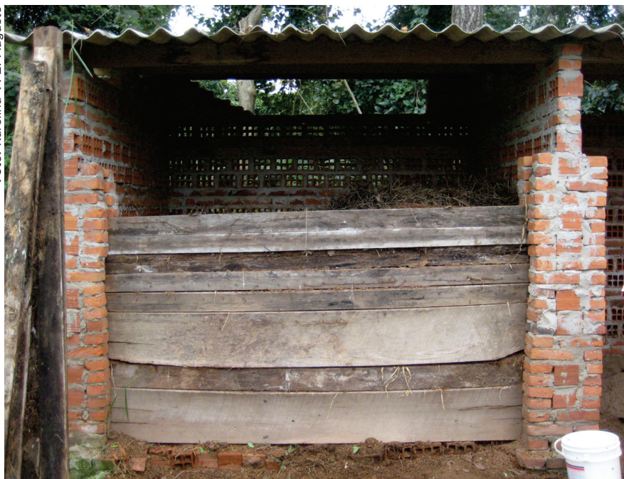
Figura 5. Baia de compostagem de mortalidade
