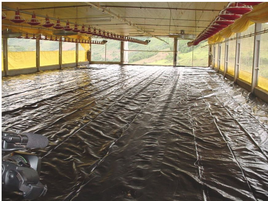
Figura 2. Cobertura com lona no aviário (fermentação plana)
