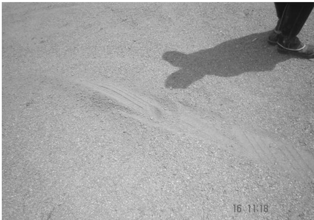
Figura 3.1. Material com baixa resistência à abrasão na condição seca. Foto: Alfredo Mendes d'Ávila.
