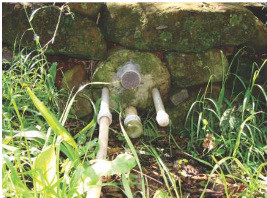
Figura 2. Fonte destacando a parte da frente do tubo de concreto e os canos PVC devidamente concretados
