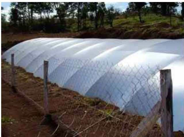
Figura- Cisterna para o armazenamento da água de chuva captada.
