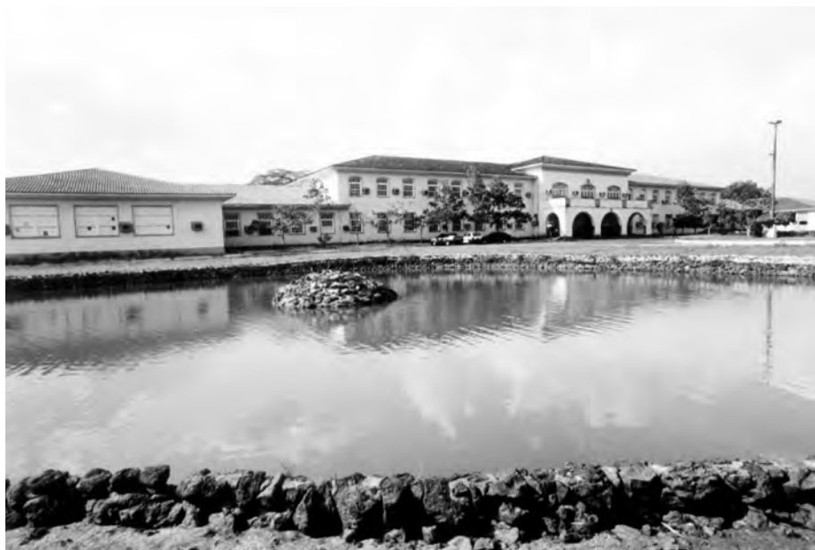
Pavilhão central da EAA, atual Universidade Federal Rural da Amazônia.
