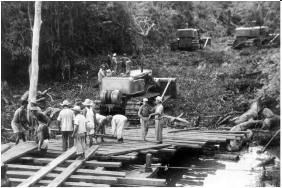
As obras movimentaram dezenas de homens e máquinas.
