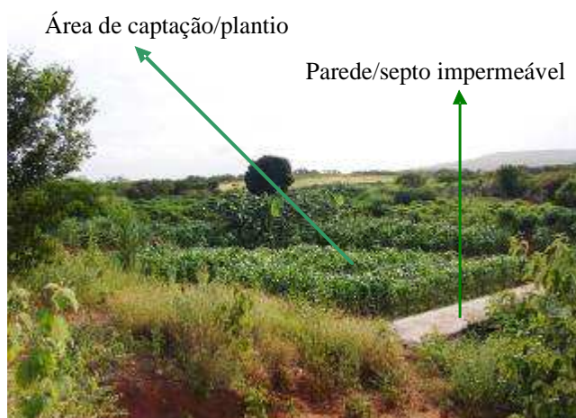
Figura 1. Barragem subterrânea. Ouricuri, PE, 2007.
