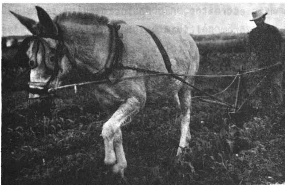
Figura 5. Cultivador a tração animal em funcionamento. A. balancim; B. balaio de arame.
