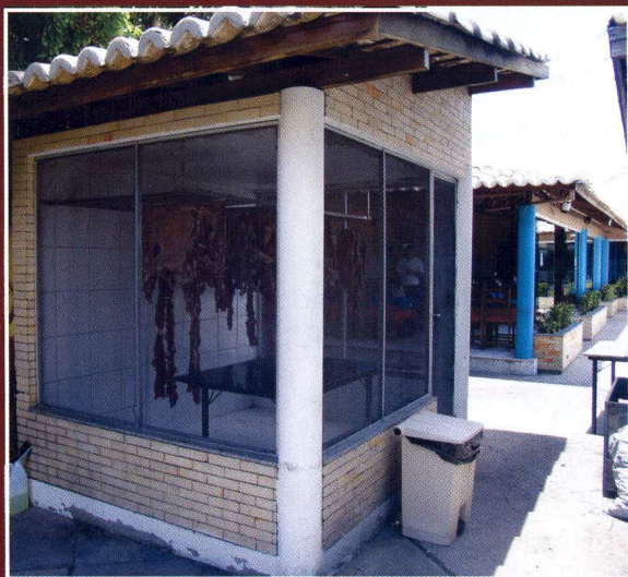
Cabine em alvenaria para secagem das mantas
