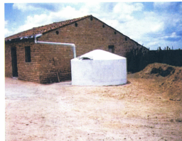
Figura 3.9 Cisterna tipo placa construída no semiárido brasileiro
