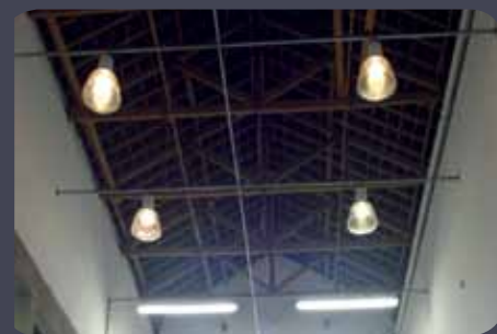
Reforma no telhado do LIE
