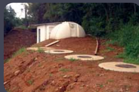
Reforma da rede de esgoto da Unidade
