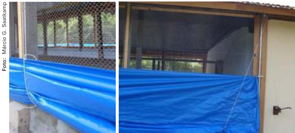
Figura 25. Detalhe da cortina.
