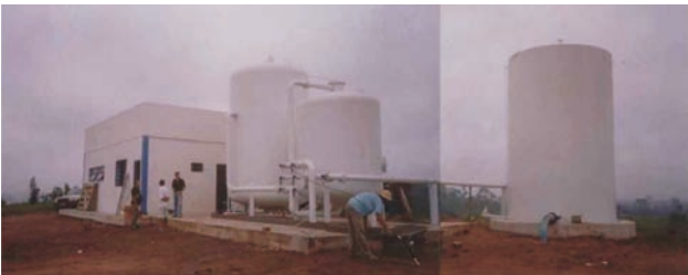
Figura 16. Estação de Tratamento d’Água em implantação na cidade de Novo Progresso
