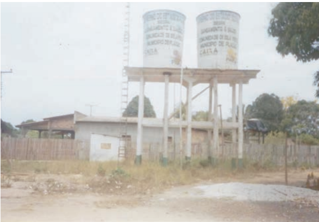
Figura 5. Poço tubular e armazenamento de água da agrovila Bela Vista, no Km-221/BR 230.
