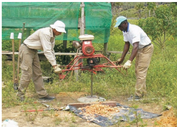
Figura 5. Sonda mecanizada acoplada a um trado cavadeira com diâmetro de três polegadas utilizada na perfuração dos poços piezômetros.
