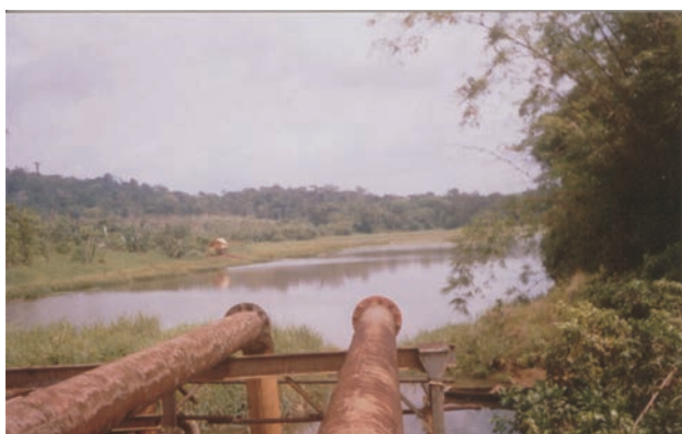
Figura 15. Captação superficial em Medicilândia.
