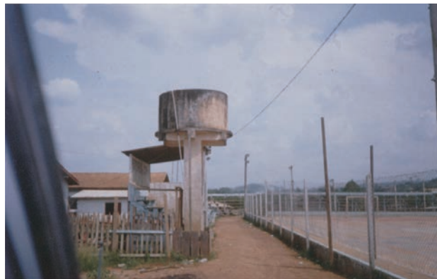
Figura 10. Poço tubular e armazenamento d'água no Inst. Municipal de Educação de Trairão.
