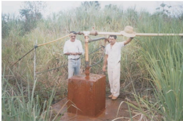
Figura 14. Poço de 370m/Km-85, da rodovia BR-230.
