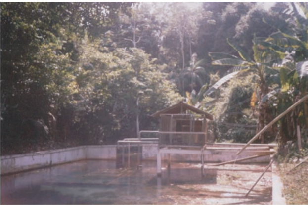
Figura 12. Captação superficial e cisterna em Belterra.
