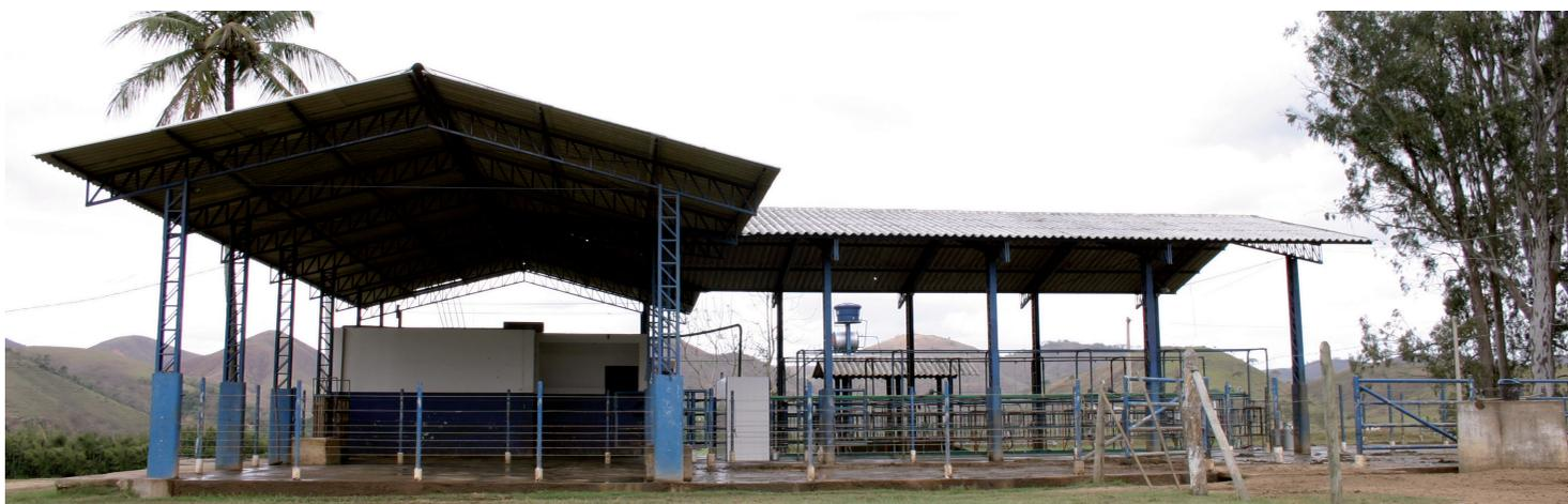
Instalações adequadas de sala de ordenha: altura de teto ideal, ventilação natural (livre de obstáculos) e presença de sombreamento natural
