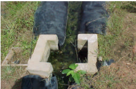
Fig. 7. Canal de abastecimento dos viveiros de terra e seu registro para a entrada independente de água.
