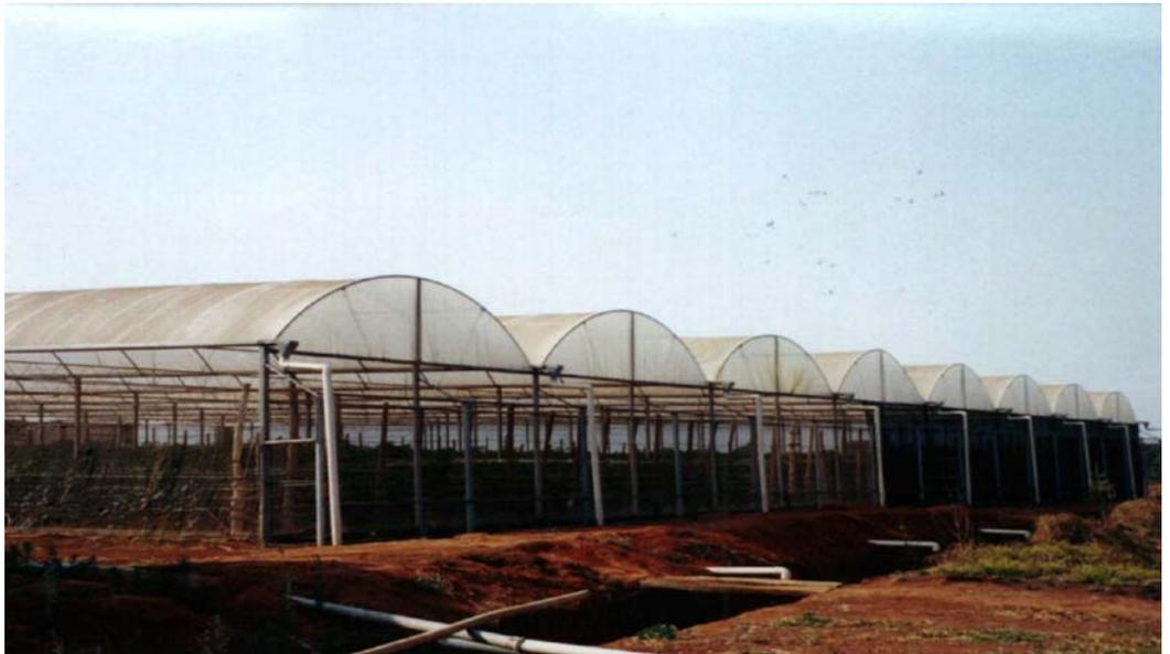
Fig. 20. Estufa modelo 'teto em arco', com geminação de oito naves, de fabricação industrial.
