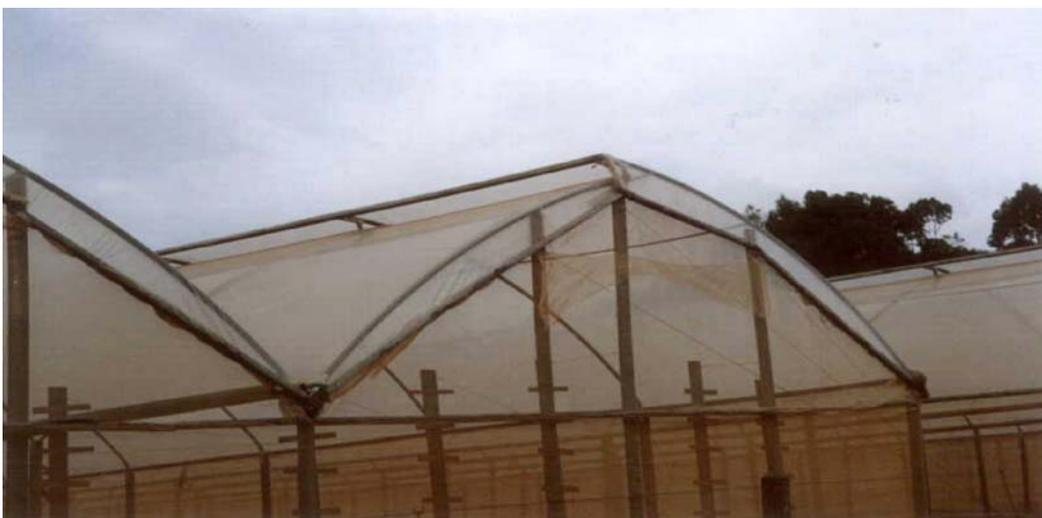
Fig. 18. Estufa modelo 'teto convectivo' de fabricação industrial.
