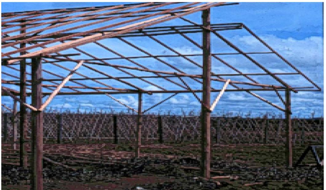
Fig. 3. Estufa modelo teto convectivo retilíneo - construído a base de eucalipto.
