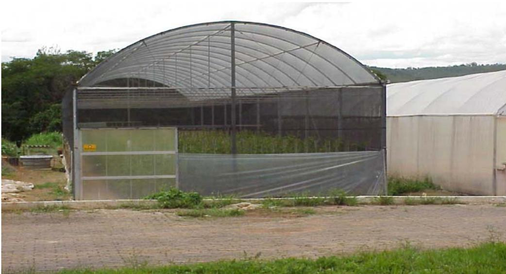
Fig. 17. Estufa modelo 'teto em arco' tipo não climatizada de fabricação industrial.
