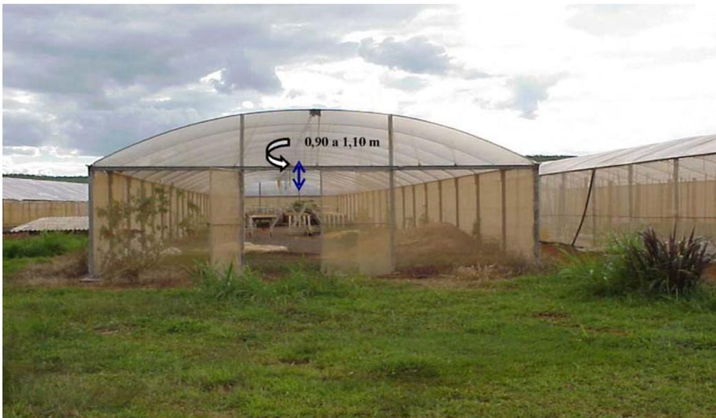
Fig. 14. Estufa modelo 'teto em arco' no formato de parábola invertida de flecha raso.
