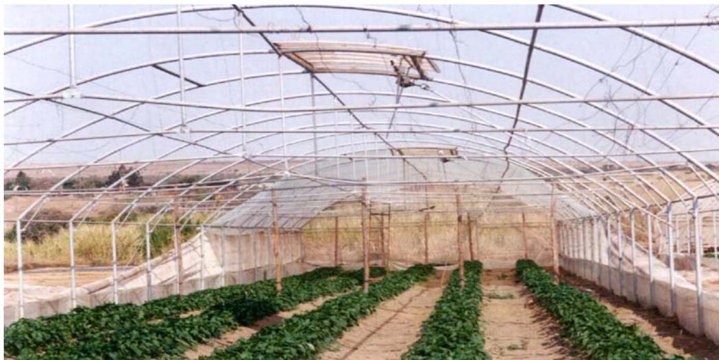
Fig. 22. Estufa modelo 'teto em arco' com janela zenital acoplada.
