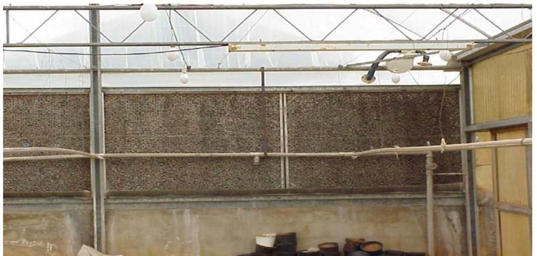
Fig. 26. Instalação de sistema de evaporação ('padfan') de estufa modelo 'teto em arco' tipo semiclimatizada.
