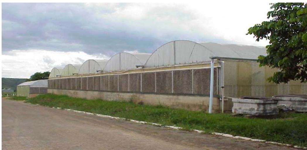
Fig. 24. Conjunto de estufas modelo 'teto em arco' geminadas e dotadas de janela evaporadora ('padfan') tipo semiclimatizada da Embrapa Hortaliças.
