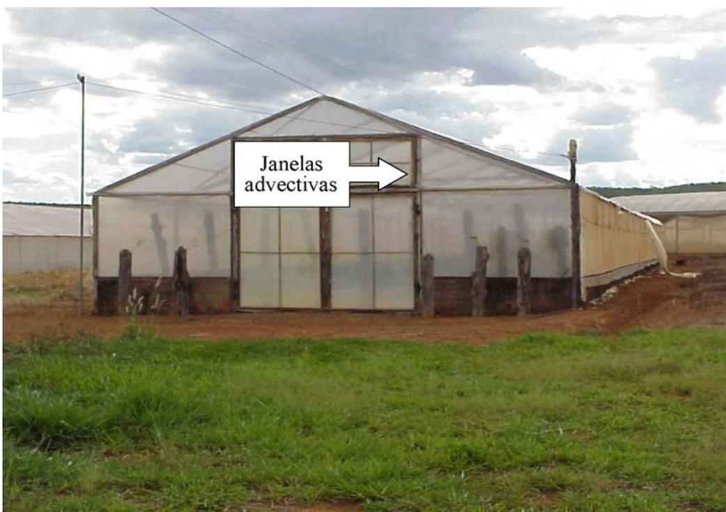
Figura 6. Estufa modelo 'capela' com janelas advectivas incorporadas.
