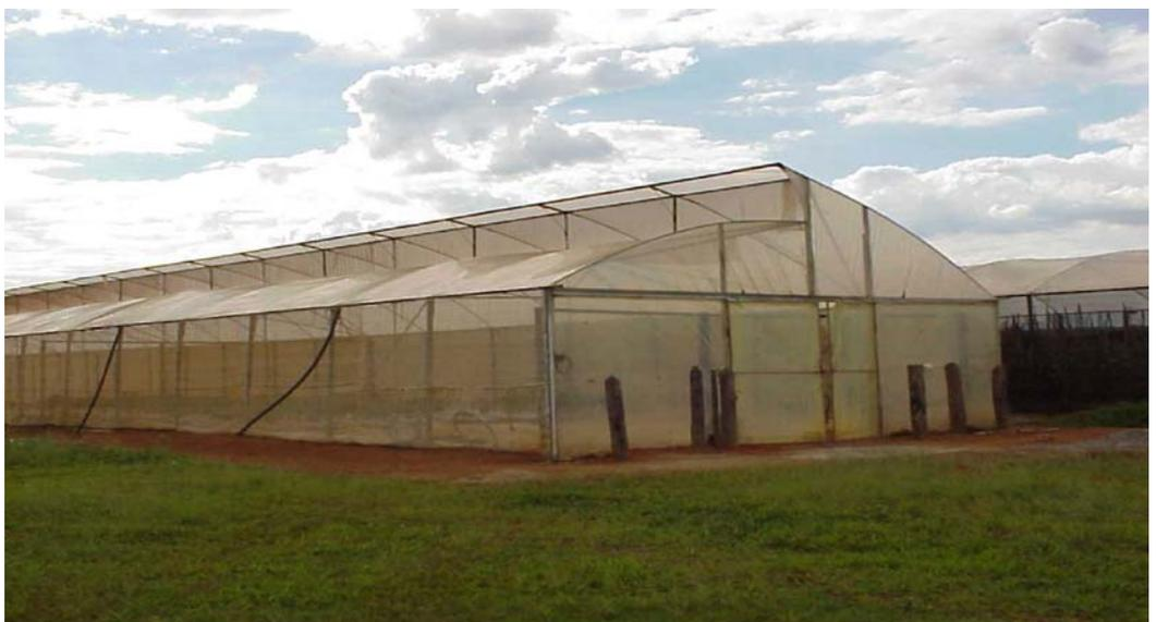
Fig. 4. Estufa modelo teto convectivo curvilíneo.
