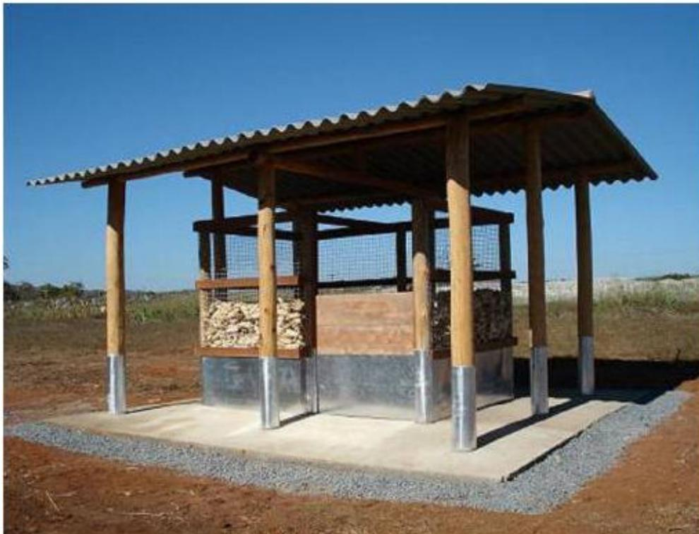
**Figura 7.** Paiol “Balaio de Milho” desenvolvido pela Embrapa Milho e Sorgo e Emater-MG, com revestimento de folhas de zinco como barreiras contra penetração de ratos.
