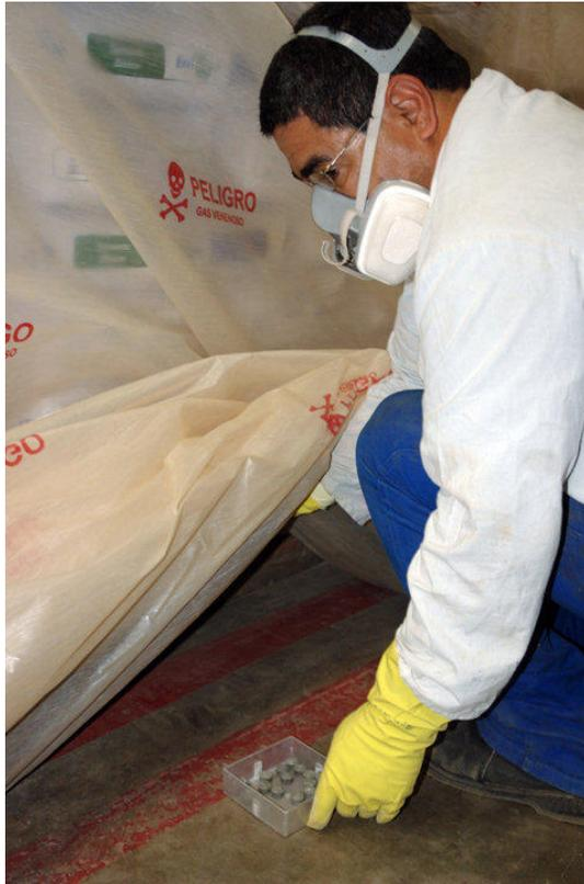
**Figura 20.** Aplicação de comprimidos ou pastilhas de fosfina nos cantos abertos da lona plástica.
