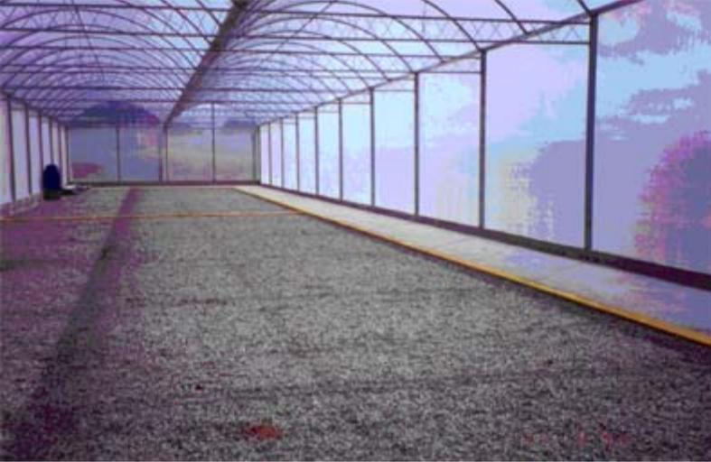
**Figura 4.** Vista interna do borbulheiro da Embrapa Clima Temperado, antes da colocação das plantas, podendo ser observado o revestimento com pedra britada e os corredores de circulação concretados.
