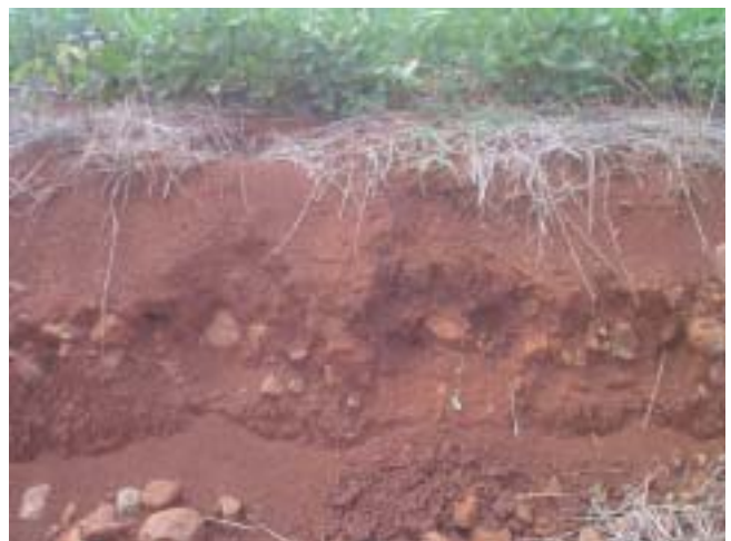
Fig. 50. Solos residuais em superfícies aplainadas de fundo de vale. Cambissolos Háplicos Eutroféricos chernossólicos.
