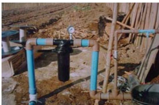
**Figura 3.** Filtros para irrigação por gotejamento
