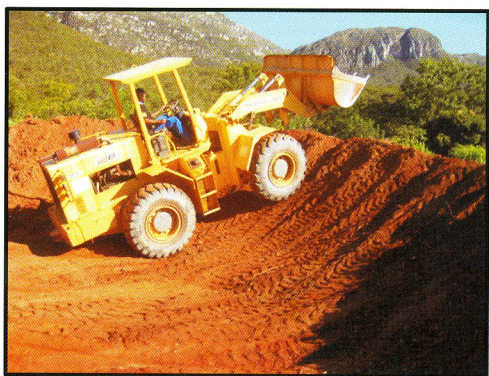
Barraginha em construção no semiárido mineiro, Porteirinha-MG
