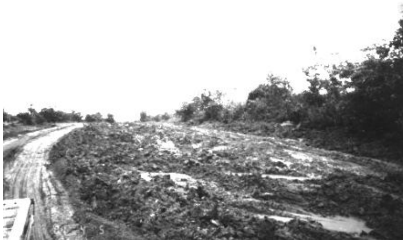
Fig. 3. Trecho em reparo da RO 133, cerca de 20 km da Usina de Calcário de Pimenta Bueno.
