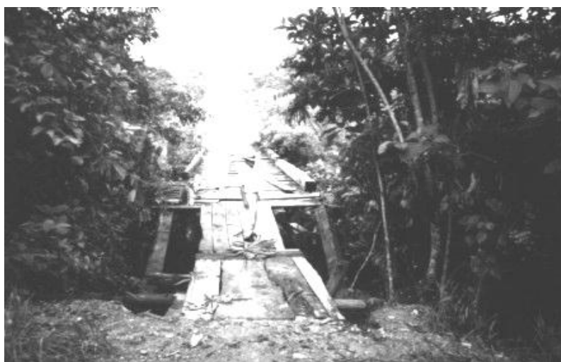
Fig. 5. Ponte sobre o Rio Francisco Bueno (RO 482), cerca de 31 km da UCPB.
