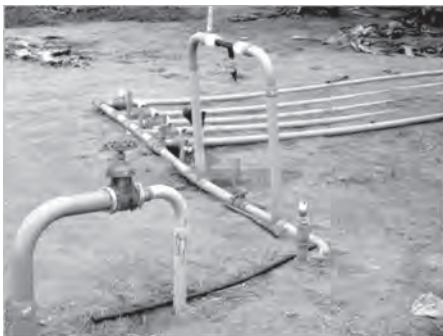
Fig. 10. Instalação do Venturi em “by pass”.
