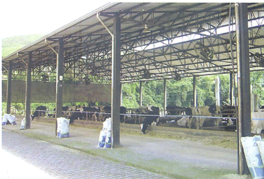
Galpão com ventiladores acionados quando a temperatura atinge 20°C, serviu de base do experimento
