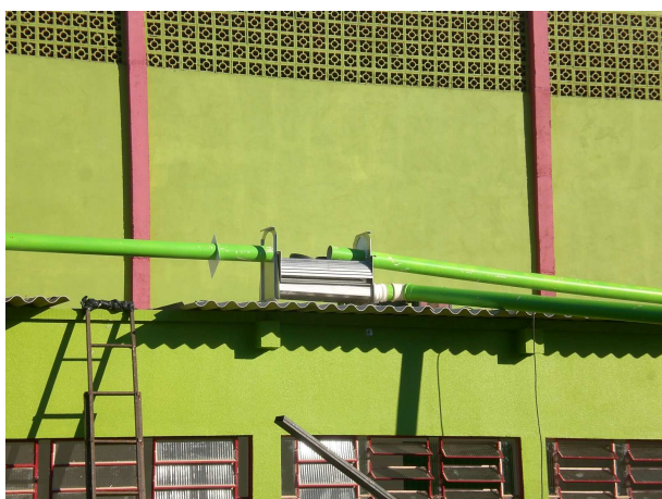
Figura 10. Dispositivo de descarte de sólidos
