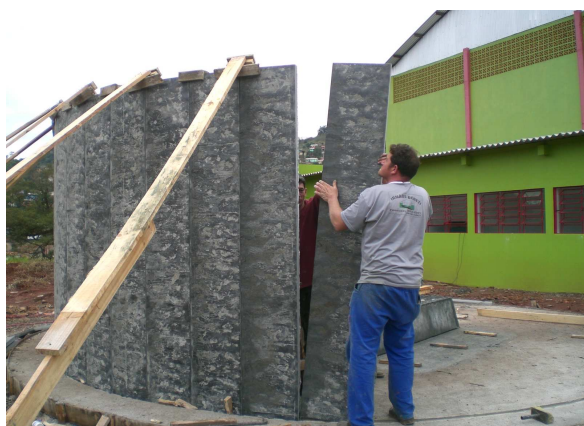
Figura 4. Montagem das placas de ardósia
