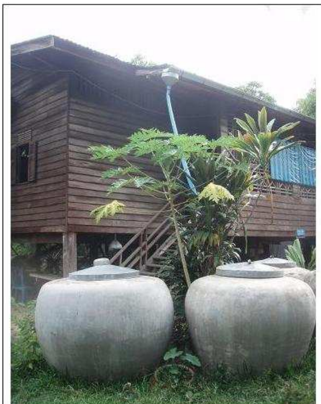
Fig. 2: Casa com instalação de jarras de água de chuva potável em Buriram, Foto: Gnadlinger, 2009.
