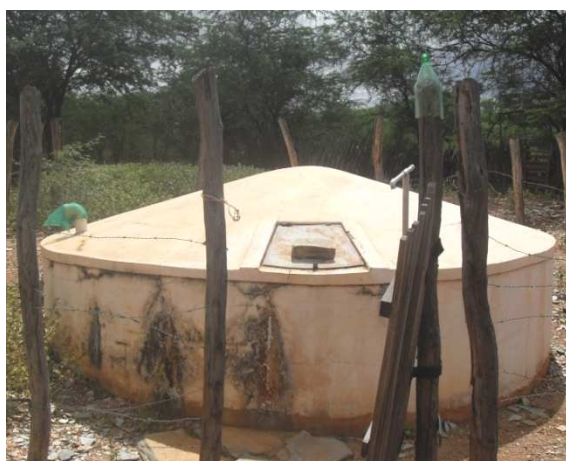
Figura 06 – A cisterna está localizada em uma propriedade privada, entretanto, todos da comunidade têm acesso com a condição de não haver desperdício. Foto: Elisson César, 2009.
