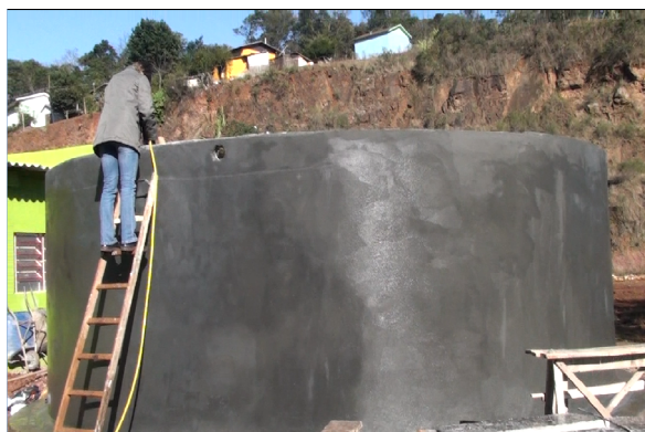
Figura 9. Cura do reservatório de ardósia
