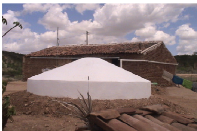
Figura 4. Cisternas de placas pré-moldadas, modelo P1MC. Fonte: Pesquisa de campo, 2008
