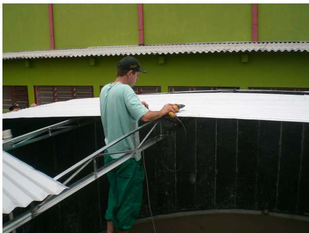
Figura 12. Montagem da cobertura metálica do reservatório
