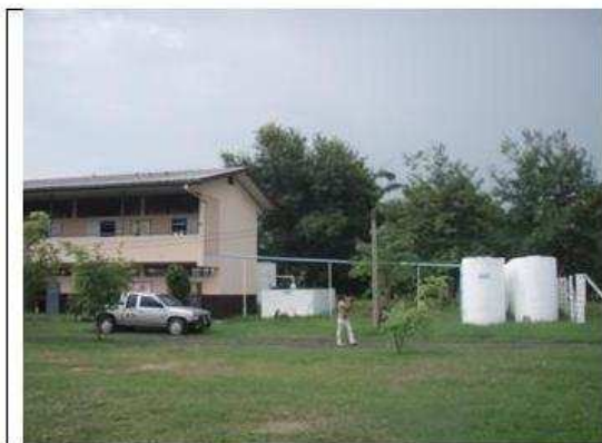
Fig. 3: Escola rural com bateria de 6 cisternas de 11.000 litros Foto: Gnadlinger, 2009
