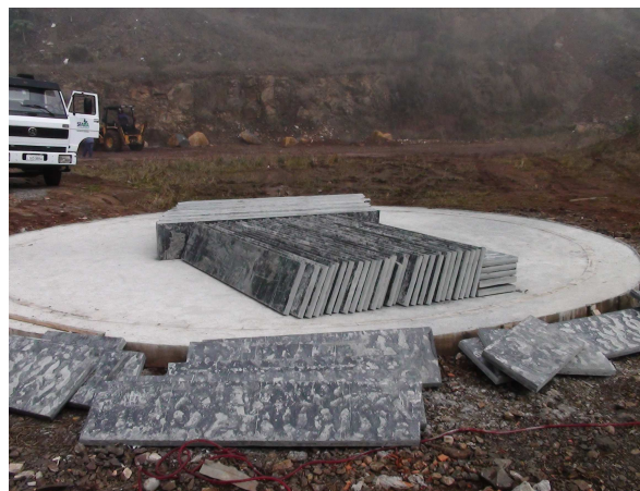
Figura 2. Placas de ardósia medindo 250 x 40 x 5 cm
