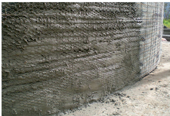
Figura 8. Armadura com tela soldada, aços complementares espessadores e tela para sustentação da argamassa
