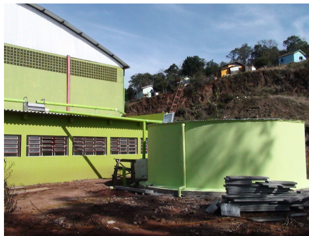
Figura 13. Vista geral do reservatório pintado
