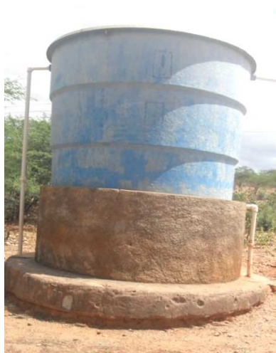
Figura 02 – Caixa que armazena a água captada do poço artesiano, perfurado há 20 anos na comunidade de Tapera. Foto: Elisson César, 2009.
