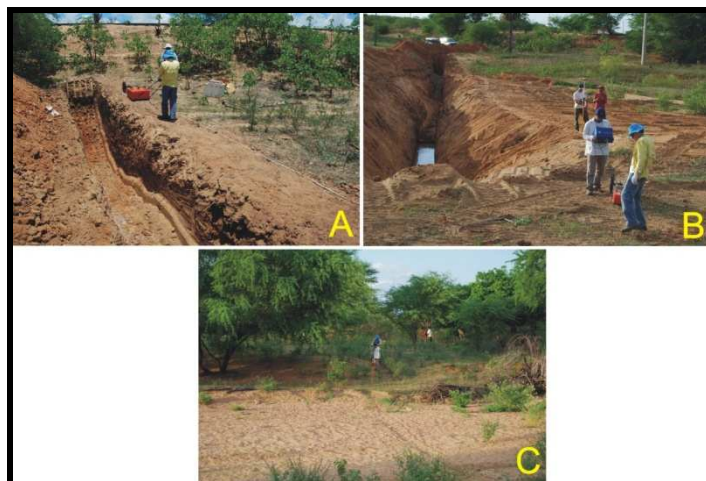
Figura 3. Etapas da utilização de GPR para locação de barragem subterrânea. (A) Início da linha; (B) Linha aproximadamente no meio da calha do rio e; (C) Término da linha de GPR, no lado oposto do rio.
