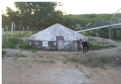
Figura 4. Cisternas de placas pré-moldadas, modelo P1MC. Fonte: Pesquisa de campo, 2008
