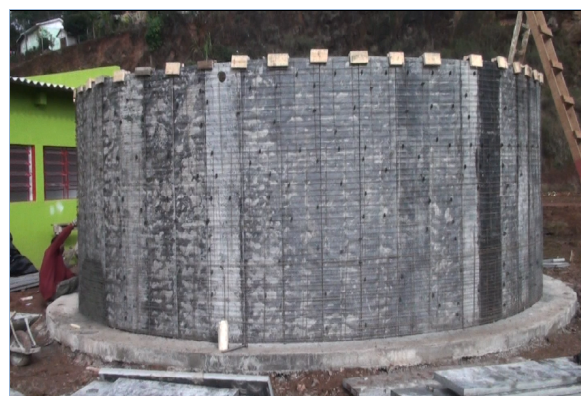
Figura 7. Armadura do reservatório de placas de ardósia
