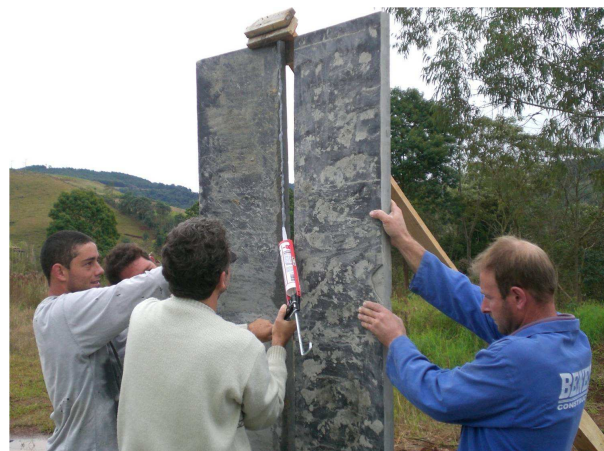
Figura 3. Levantamento das placas de ardósia
