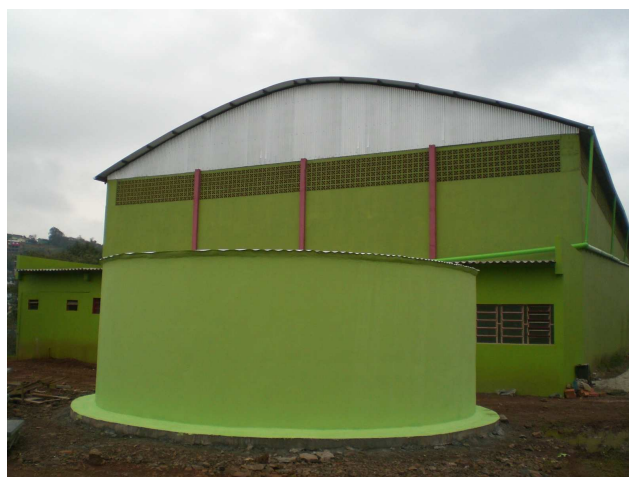
Figura 14. Vista do reservatório de placa de ardósia
