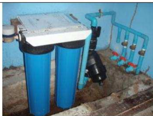
Fig. 4: Filtro de carvão e ionização de prata Foto: Gnadlinger, 2009
