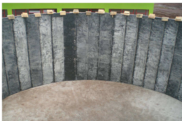
Figura 6. Vista interna do reservatório de placas de ardósia
