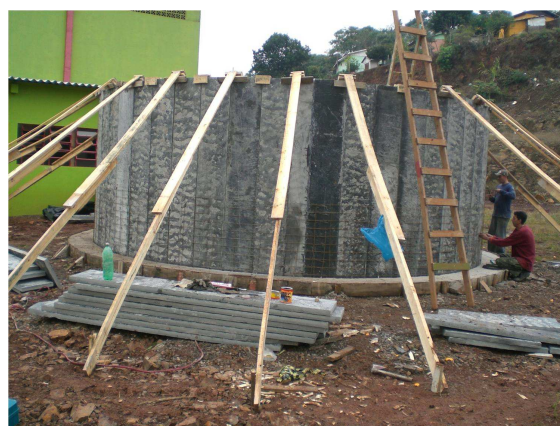
Figura 5. Escoramento das placas de ardósia
