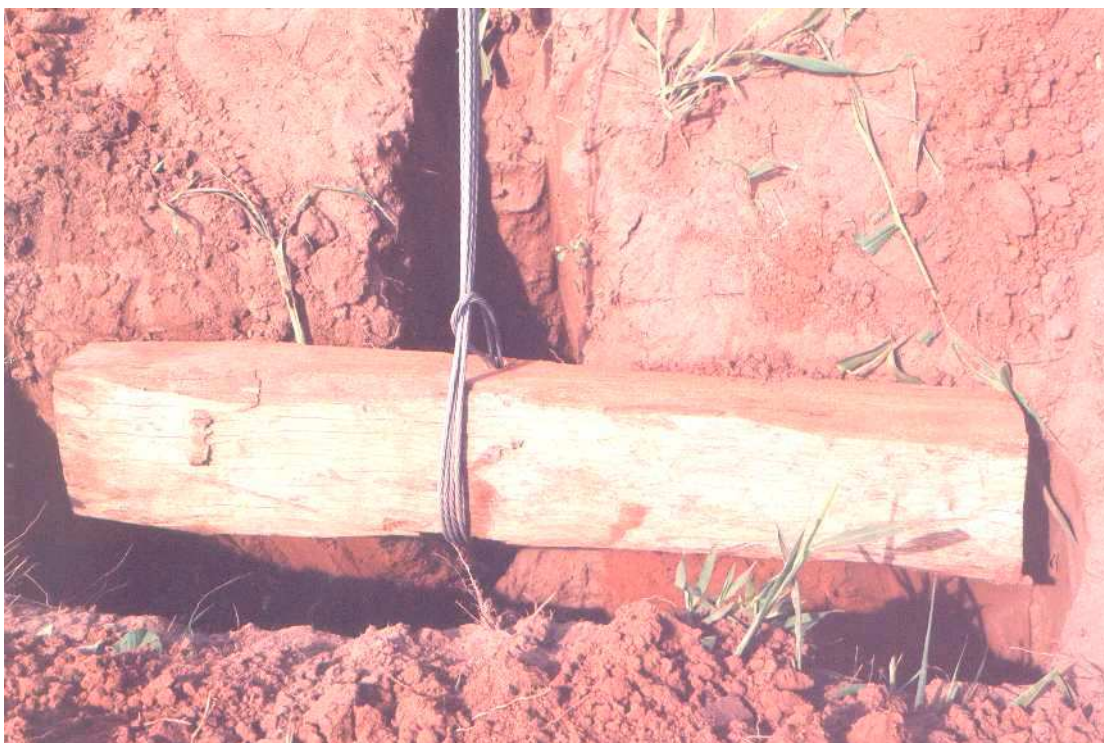
Fig. 3. Colocação de rabichos nas extremidades das linhas (Foto: J. D. G. Maia).
