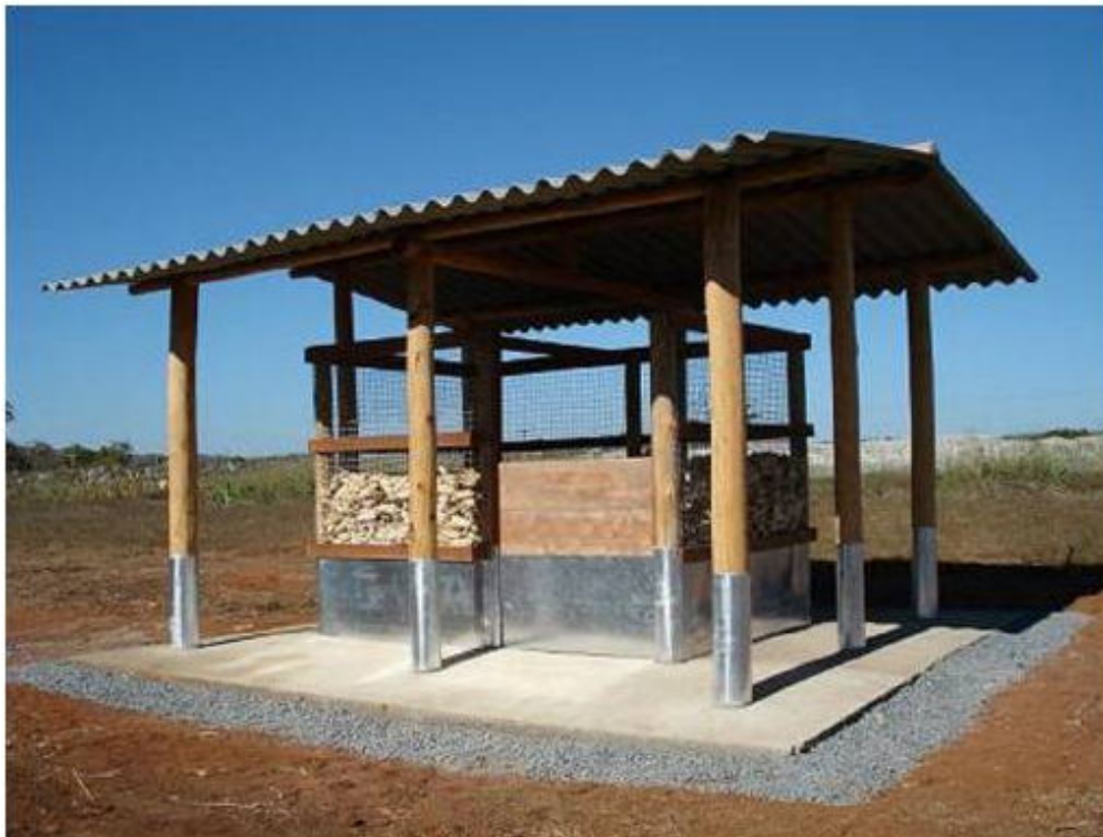
Figura 7. Paiol “Balaio de Milho” desenvolvido pela Embrapa Milho e Sorgo e Emater-MG, com revestimento de folhas de zinco como barreiras contra penetração de ratos.
