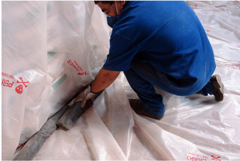
Figura 19. Cobertura das laterais da lona com “cobras de areia”.
