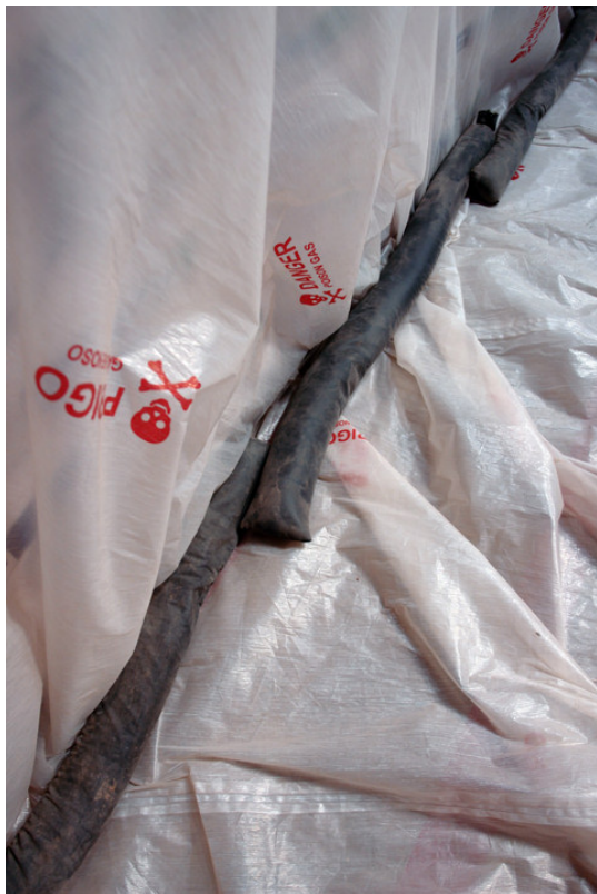
Figura 21. Detalhe da colocação das “cobras de areia” de forma justaposta para evitar o vazamento do gás fumigante.
