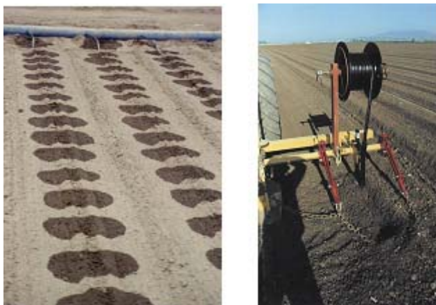
Figura 17. Sistema de irrigação localizada subsuperficial instalado com detalhe do equipamento de instalação à direita.
