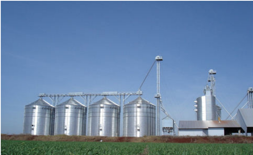
Figura 6. Unidade armazenadora com conjunto de silos metálicos, transportadores e secador de torre.
