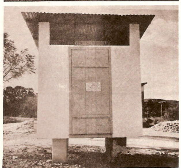
Paioi de alvenaria erguido sobre pilares.
