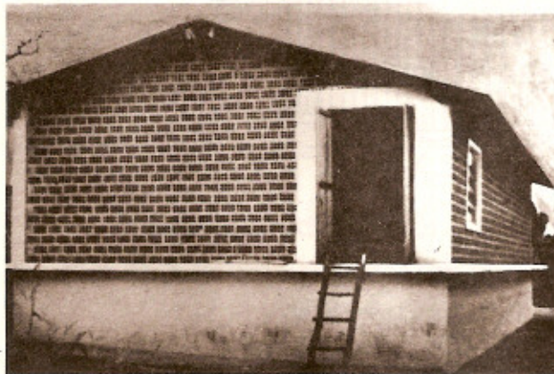
Paioi de alvenaria ventilado, construído ao nível do solo e com proteção anti-rato.
