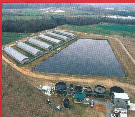
Figura2: Estação de Tratamento de Dejetos Suínos (ETDS) nos Estados Unidos
