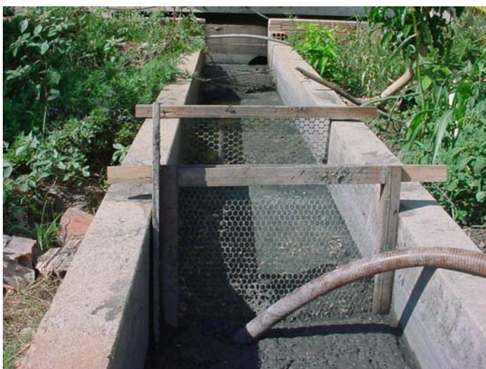
Fig. 4. Colocação de telas nas canaletas de dejetos
