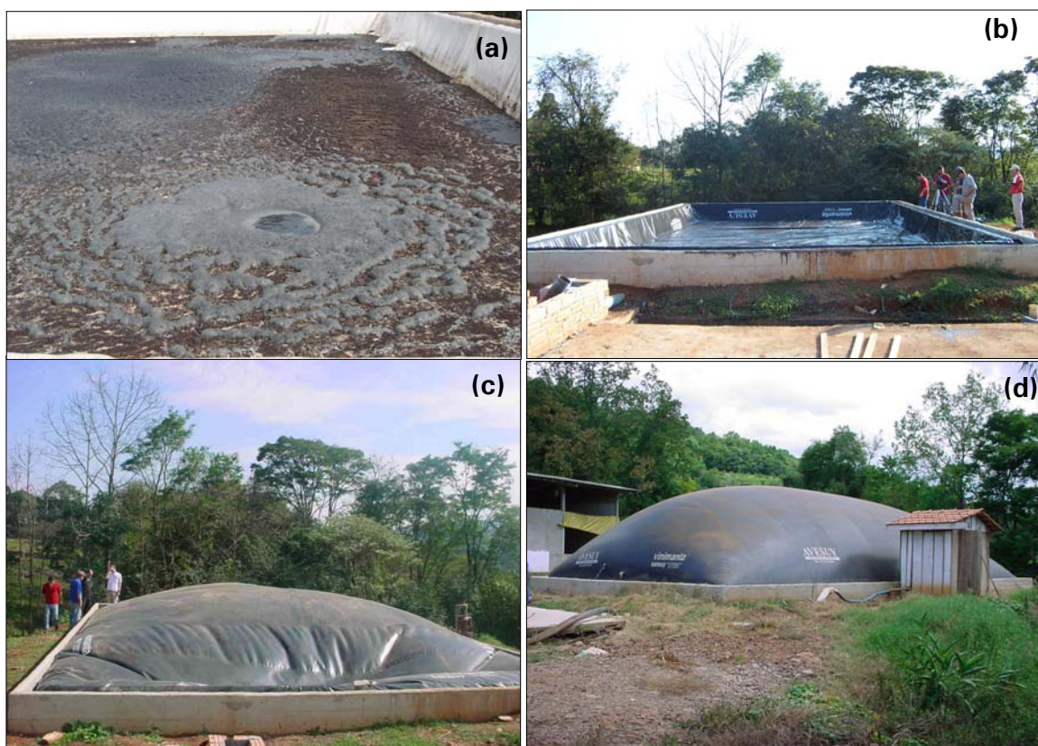
Fig. 1. Detalhe do dejetos sob agitação (a), após fechamento do biodigestor (b), início da produção de biogás (c) e com o gasômetro completamente cheio de biogás (d).
