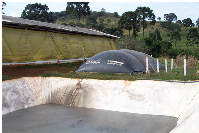
Figura 3 - Biodigestor modelo canadense e depósito de biofertilizante revestido em lona de PVC, para a produção de biogás e armazenamento de resíduo.
