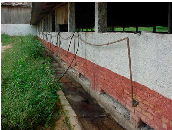
Figura 1 – Construção típica em alvenaria para a produção de suínos, detalhes das paredes laterais e do canal de manejo de dejetos.
