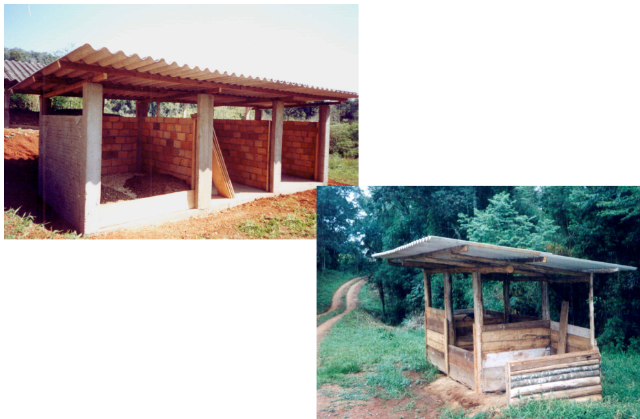
Figura 1 - Composteiras construídas em alvenaria e madeira.
