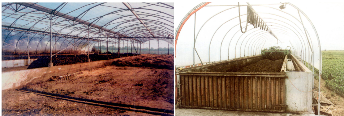
Figura 1 - Vista do sistema de tratamento dos dejetos de suínos em Plataforma de Compostagem, revolvimento com o uso de trator e revolvimento mecânico.
