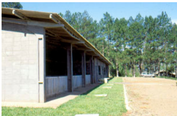
Figura 2 – Edificação para a produção de suínos em estrutura de concreto pré-fabricada, detalhe das paredes laterais e de canal para manejo dos dejetos cobertos.
