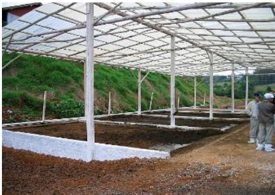
Figura 5 - Câmaras de incorporação de dejetos em leito de maravalha.
