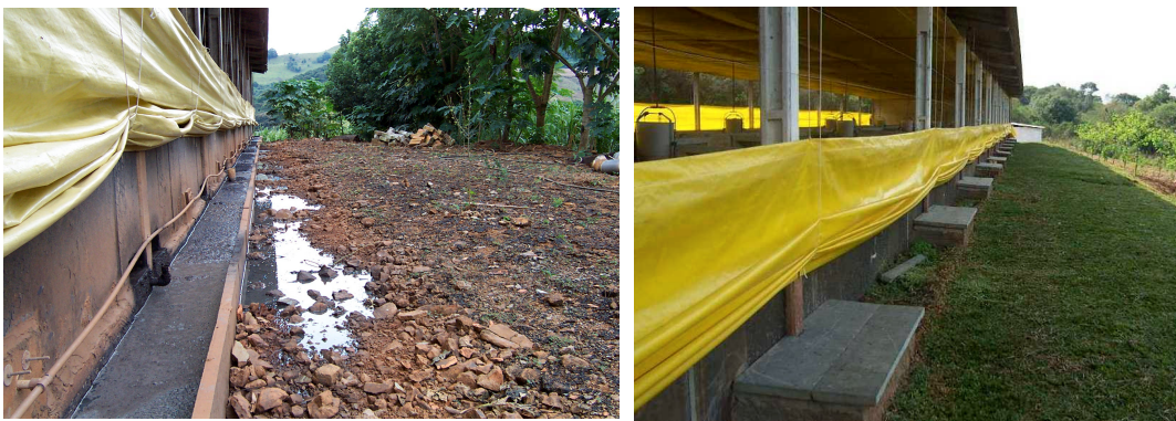
Figura 8 – Na foto a esquerda canal externo usado freqüentemente para o manejo dos dejetos e na foto a direita recomendação para a construção de canal externo coberto evitando-se a proliferação de moscas e de odores e infiltração da água da chuva.
