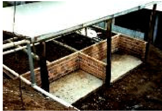
Figura 4 - Tipo de cobertura das câmaras de incorporação e compostagem.
