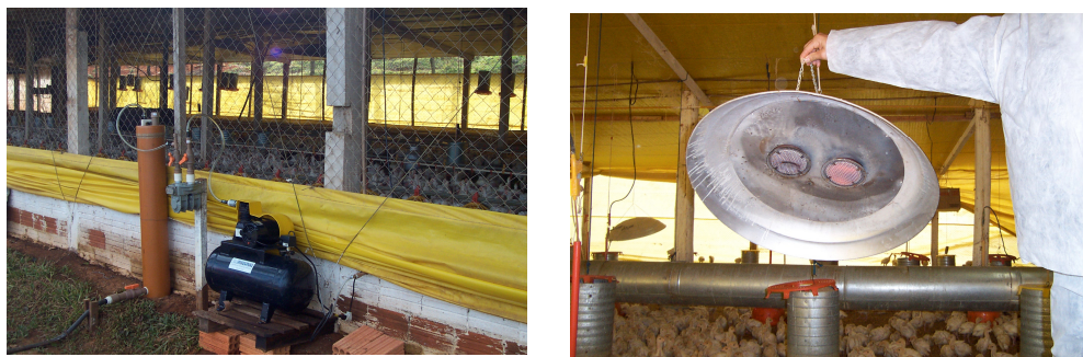
Figura 4 - Sistema de aquecimento do ambiente interno de aviário, com o uso de biogás.
