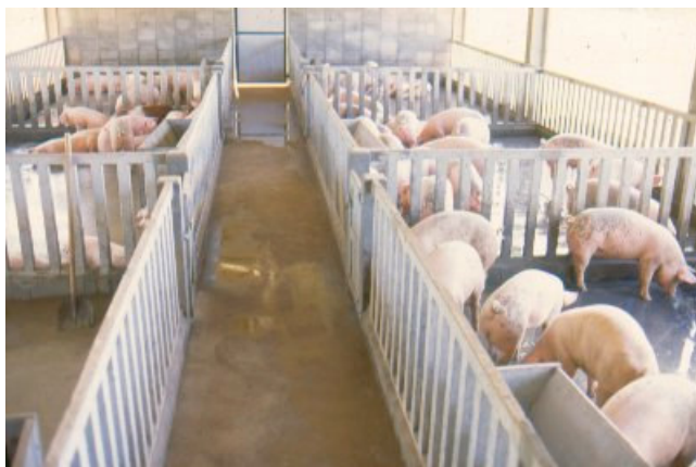
Figura 4 – Divisórias de concreto pré-fabricadas para fechamentos laterais das baias facilitando a ventilação natural.
