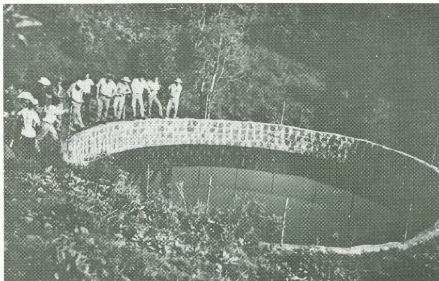
Foto 11 - Sistema de armazenamento de dejetos de suínos.
