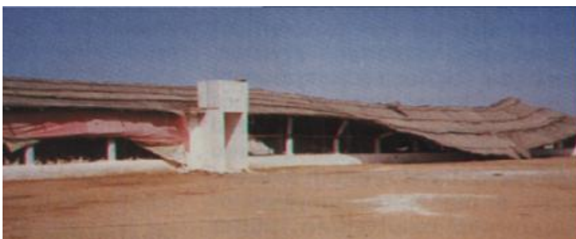
FIG. 15 - Colapso total da estrutura pela ação do vento.
