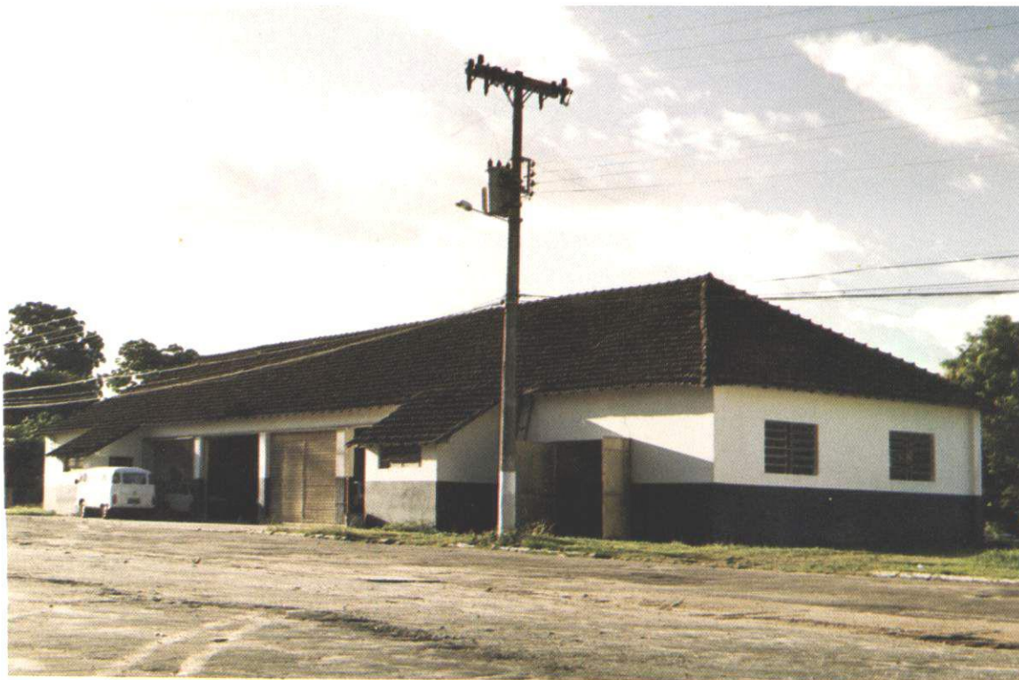
Prédio do Setor de Máquinas e Veículos - Garagem e Oficina de Veículos.
