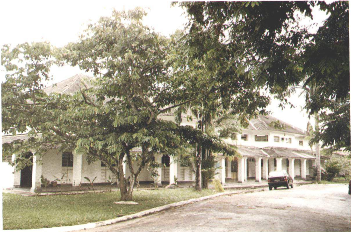
Prédio do Laboratório de Solos e Plantas.
