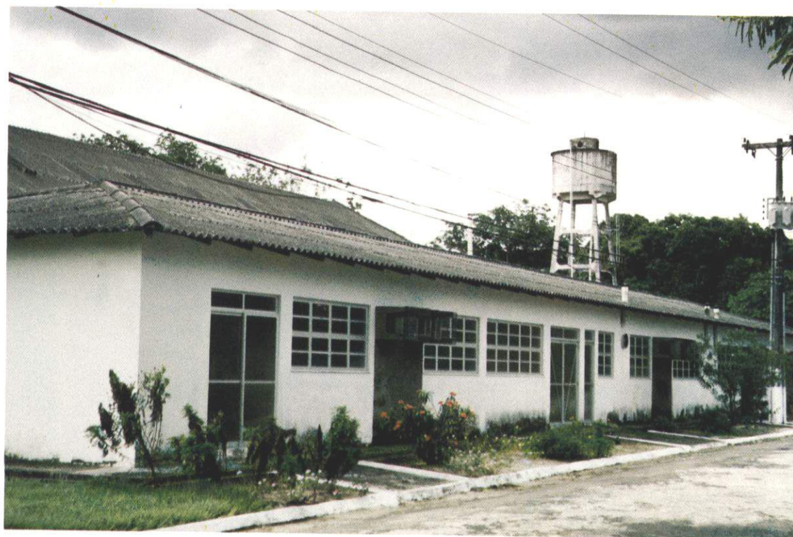
Prédio anexo do Laboratório de Agroindústria.
