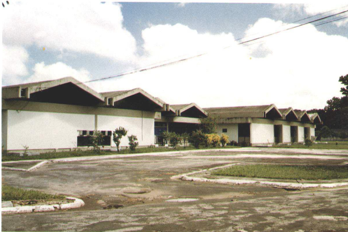
Prédio da Biblioteca Central e Área de Informática.
