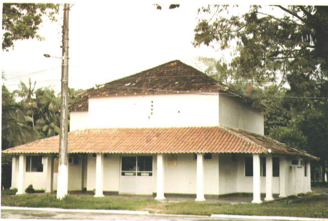
Prédio dos Convênios Nacionais e Internacionais.
