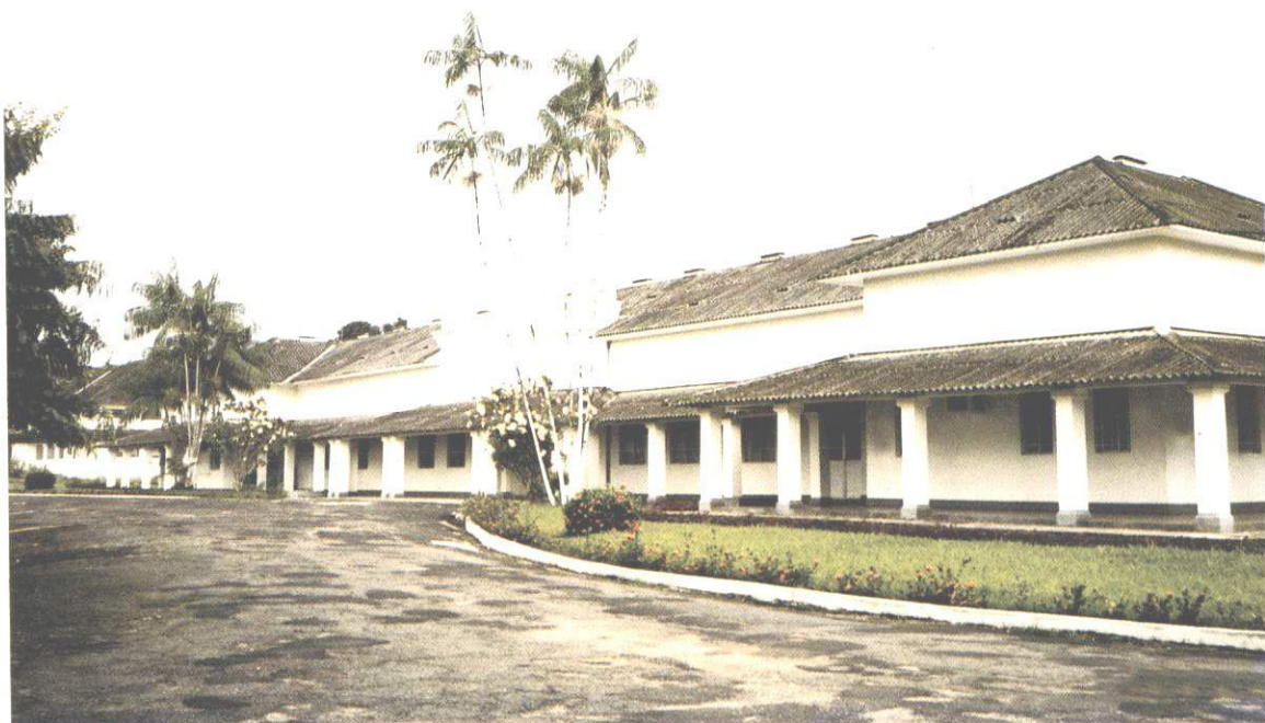
Prédio da Administração Central.
