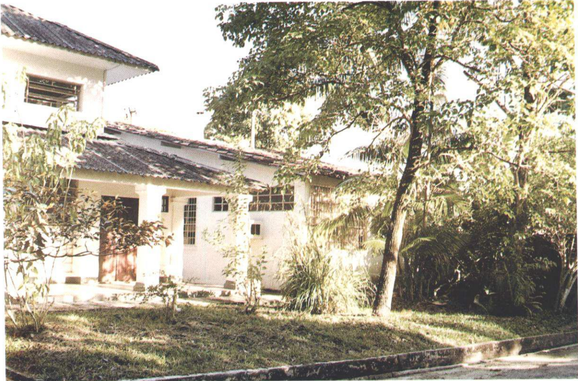
Prédio do Laboratório de Microbiologia do Solo.
