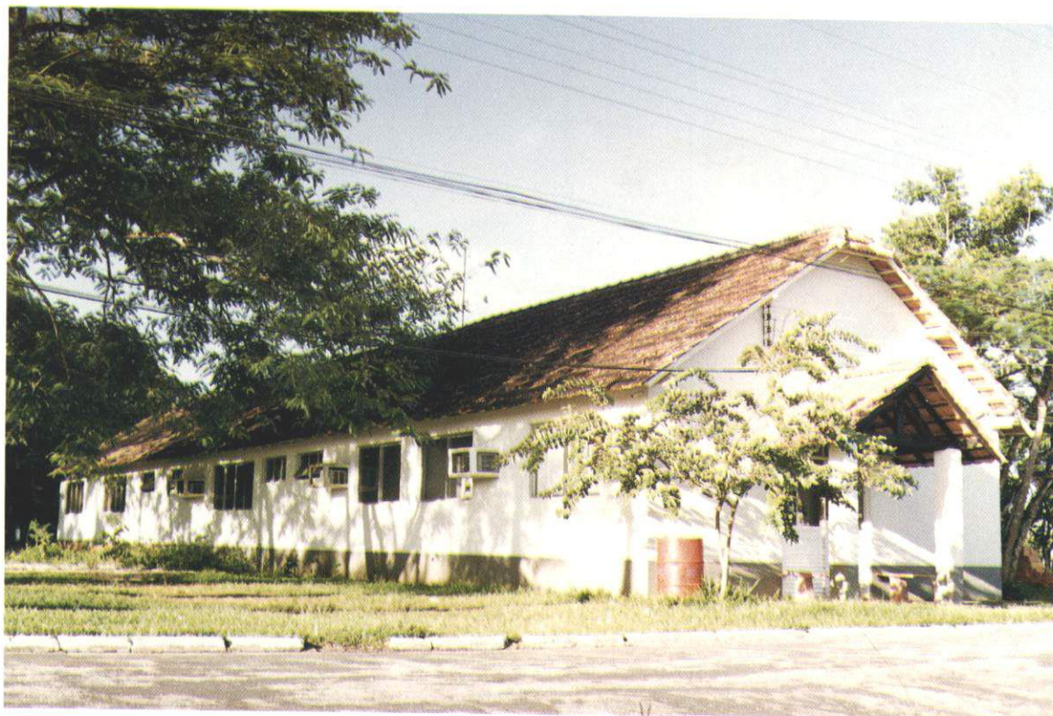
Prédio do Setor de Serviços Auxiliares.
