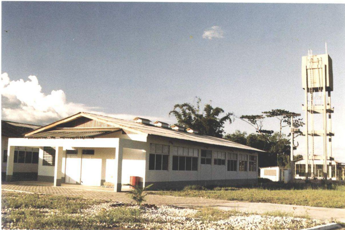
Vista do Castelo da nova Central de Abastecimento de Água.
