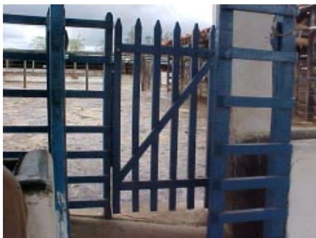
Figura 9. Cerca interna que liga os módulos 2 e 4.
