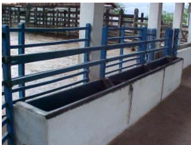
Figura 7. Ripões removíveis que separam os módulos 2 e 3.
