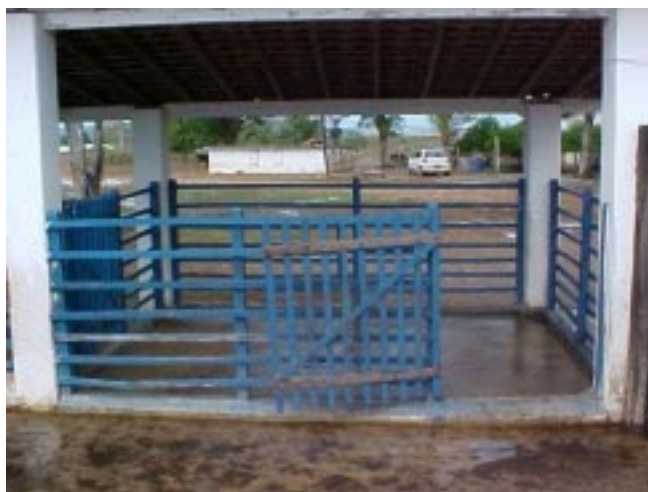
Figura 2. Portão de acesso para o módulo 1.
