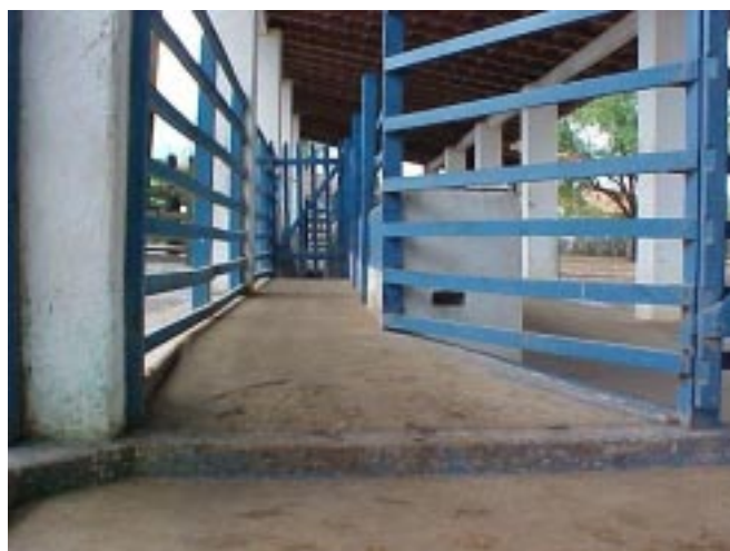
Figura 5. Rampa de acesso ao módulo 2.
