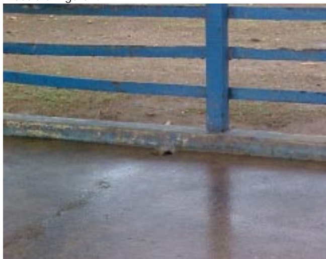
Figura 4. Detalhes do piso, da parede lateral do reservatório e da saída de água do módulo 1.
