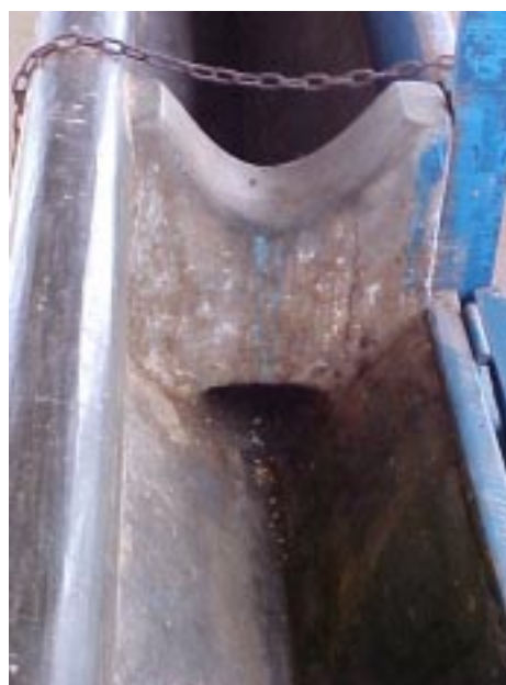
Figura 11. Aberturas entre as divisões do módulo e o exterior destinadas à limpeza.
